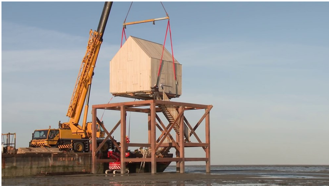
In de loop van juli werd het huisje – aan de wal gebouwd door Bouwbedrijf Jelle Bruinsma - geplaatst. Foto's Hans den Hartog
