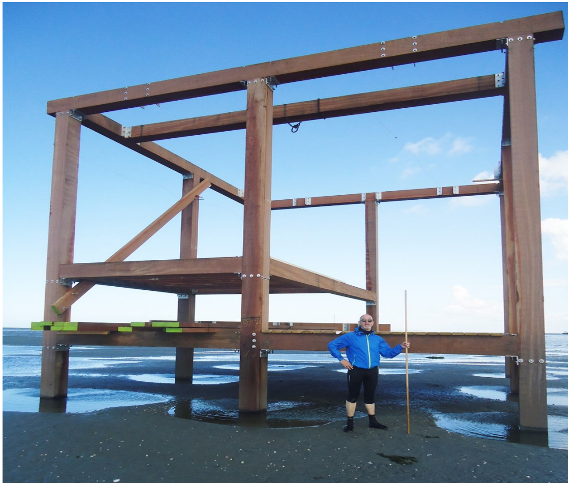
De fundering, gebouwd door Oostenhof Holman.
