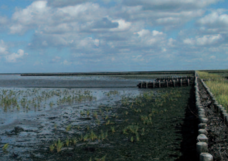
Rijshoutdam in de pionierzone met Zeekraal ( Salicornia europaea ) in de Groninger kwelderwerken (foto: Willem van Duin).
